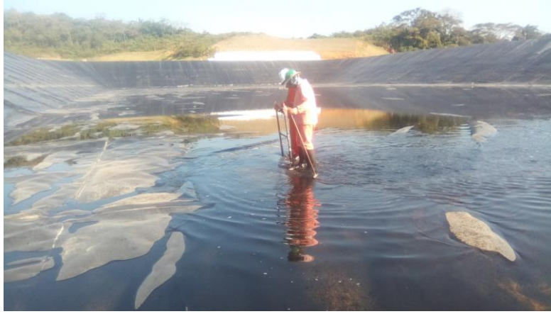
Figure 2. Contrôle au dipôle électrique mobile dans les zones sous eau
