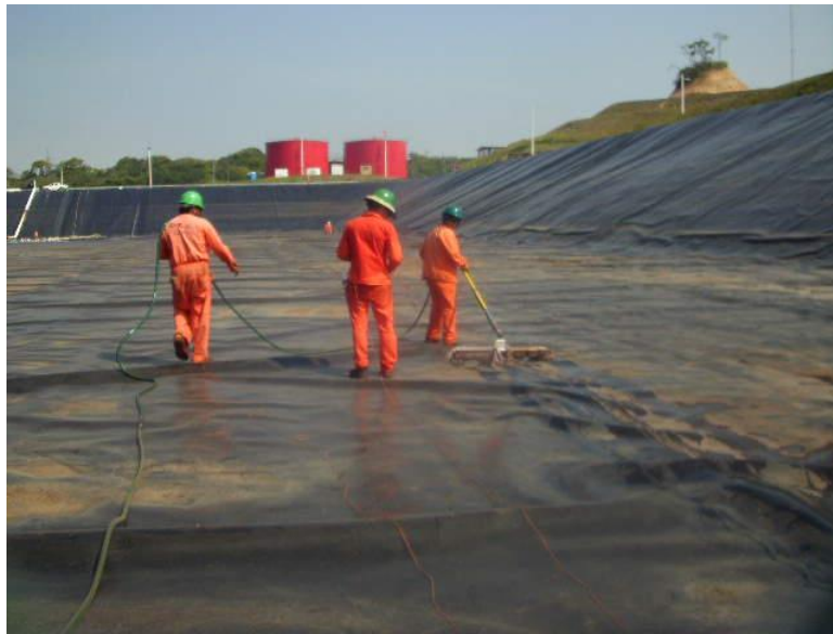
Figure 3. Contrôle au balai électrique - flaque sur les zones sèches du fond
